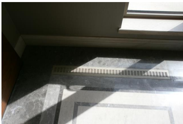
安装严密平整的地面出风口
