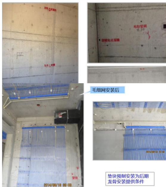
毛细管网施工前,将吊顶及墙面完成面线放出,并落实毛细管网区域位置
