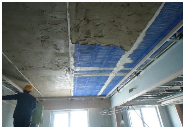
毛细管网粉刷石膏抹面
